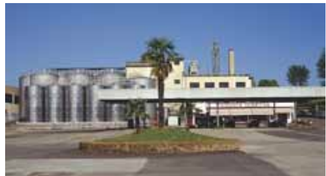
Figure 40 - Cantina Sociale in Castelnuovo di Garda
